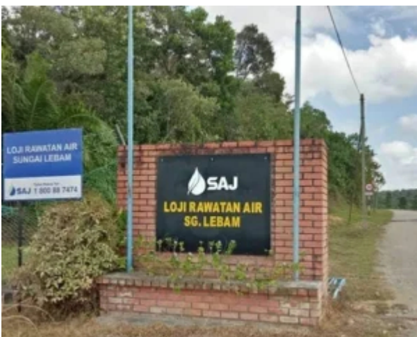
Loji Rawatan Air Sg. Lebam, Johor Developer: Pengurusan Aset Air Berhad
